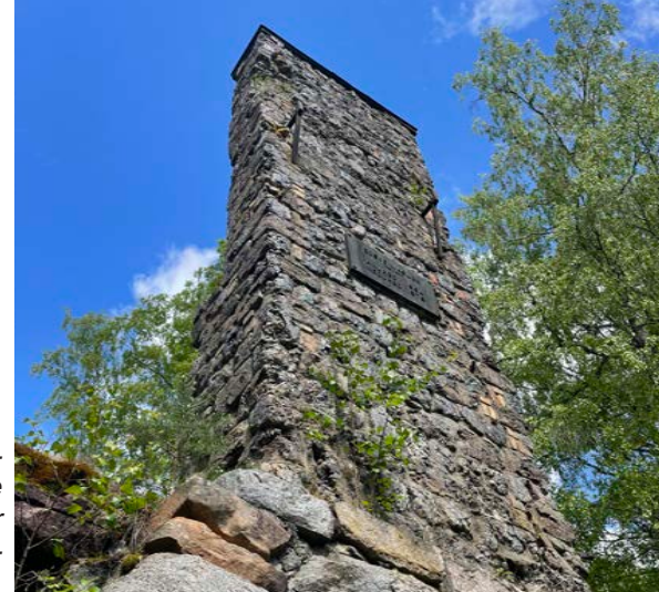
Träd slår rot i masugns- ruinen. Dessa skulle behöva avlägsnas för att inte påskynda bygg- nadsresternas förfall.
