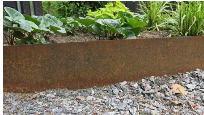
Rosttrögt stål, även kallat corténstål, kan t ex användas för att skilja olika markmaterial åt. Bild hämtad från Outdoor Design.
