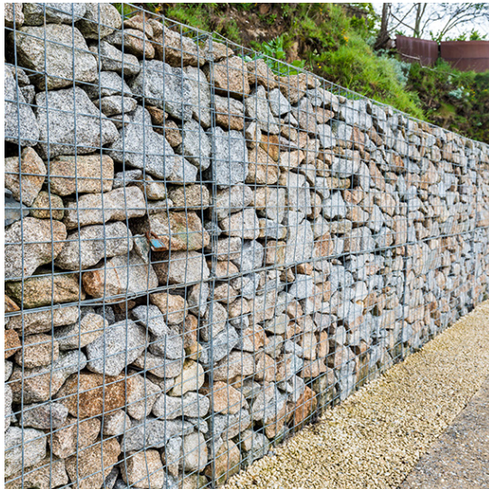
Exempel på gabioner, dvs natursten i metallburar utan murbruk.
