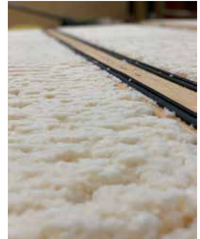
Demonstration av inblåst träfiberisolering (Termoträ) i väggar. Inga sättningar förekommer.
