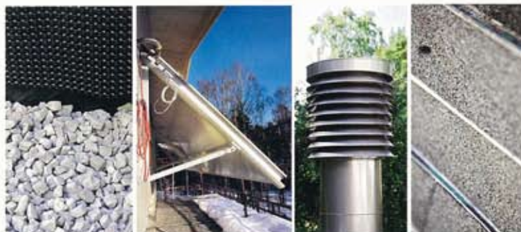
Bilder fr. v. till h: Isolerande skumglasgrus. Solfångare från Schüco sitter på väggen. Luftintag för ventilation. Foamglasskivor.
