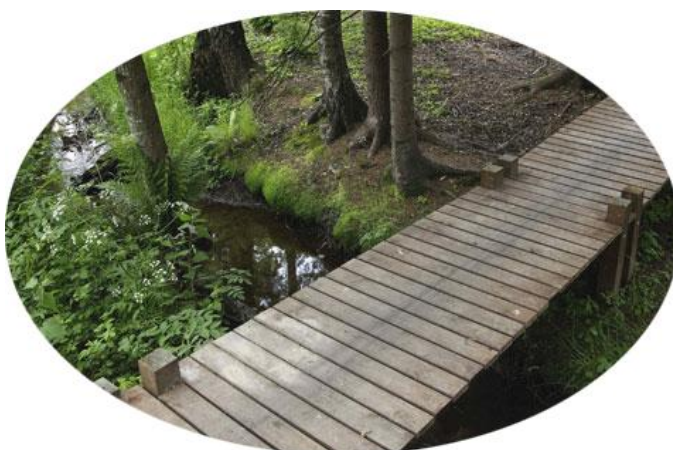
Exempel på liten bro över dike.
