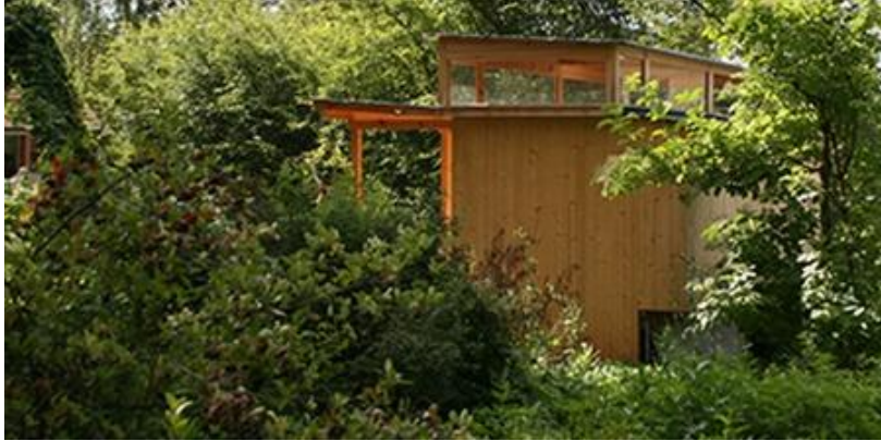
Förrädsbyggnad, exempel på miljöbod, arkitekt Lars Gezelius
